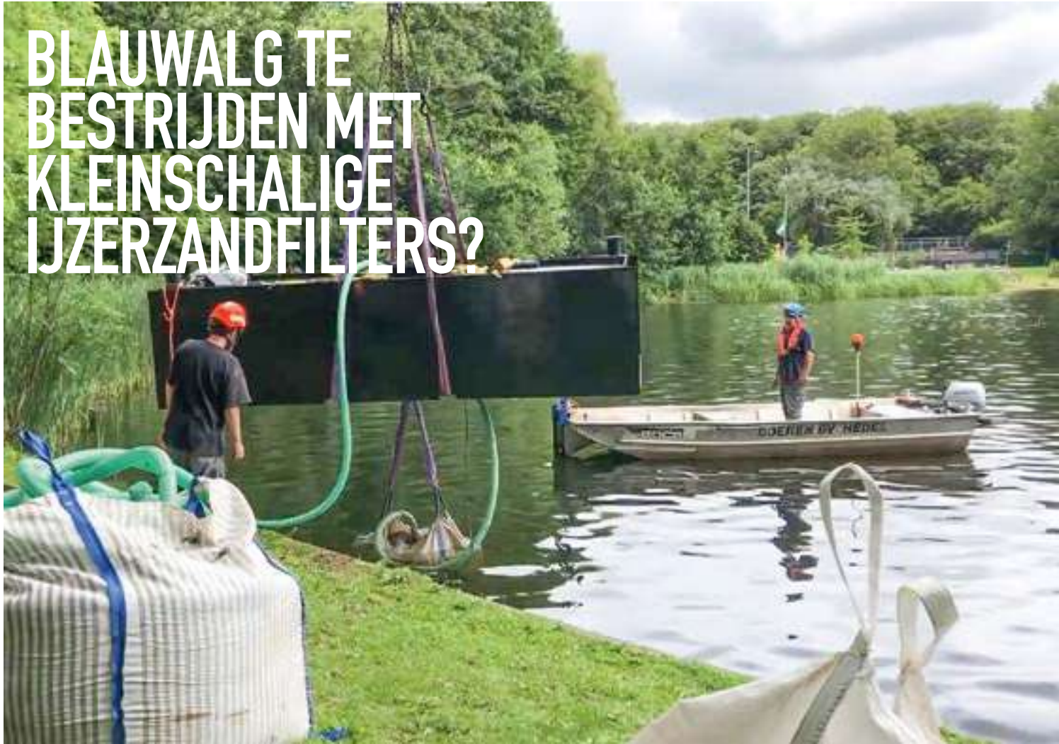
Drijver met big bag wordt in de plas geplaatst
